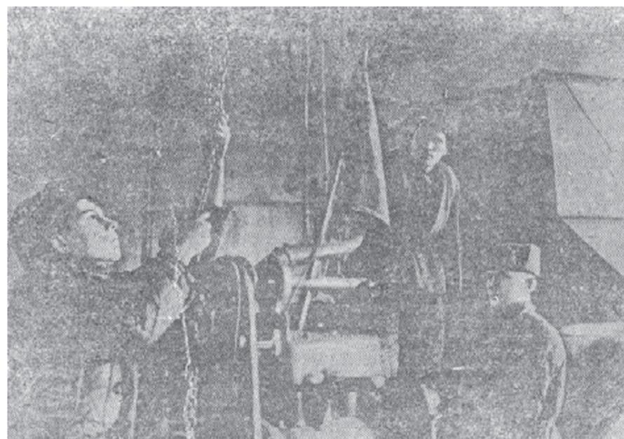
■ Ремонт комбайнов по бригадно-узловому методу Кемеровской МТС. Моторемонтная бригада, которой руководит т. Саблин, устанавливает мотор на комбайн. Фото А. Фатеева.
