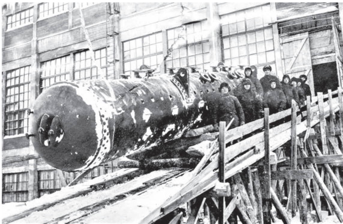
■ Установка барабана котла на Кемеровской ГРЭС. 1940-е годы.
