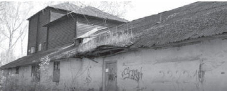
Школа Кемеровского рудника.
