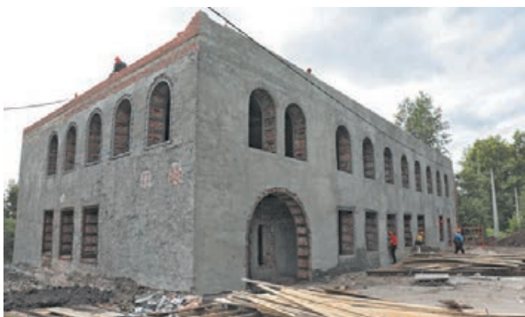
■ Капитальный ремонт поликлиники в Анжеро-Судженске.
