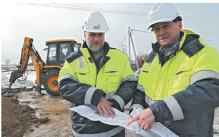
■ Бестраншейный метод даёт возможность проложить под землёй новый трубопровод и сохранить благоустройство территории.
