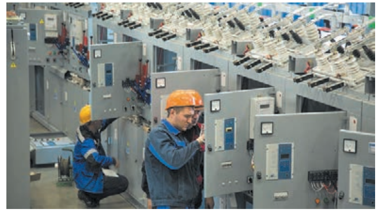
Сборка ячеек КСО в филиале «Энергосеть г. Кемерово».
