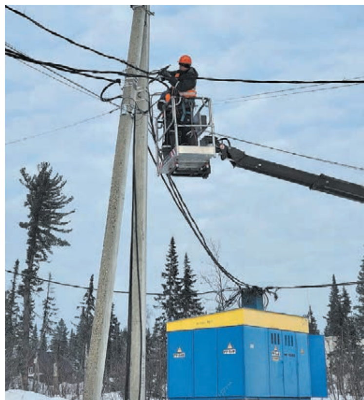
Монтаж ВЛ 0,4 кВ на линиях спортивно-туристического комплекса «Шерегеш».
