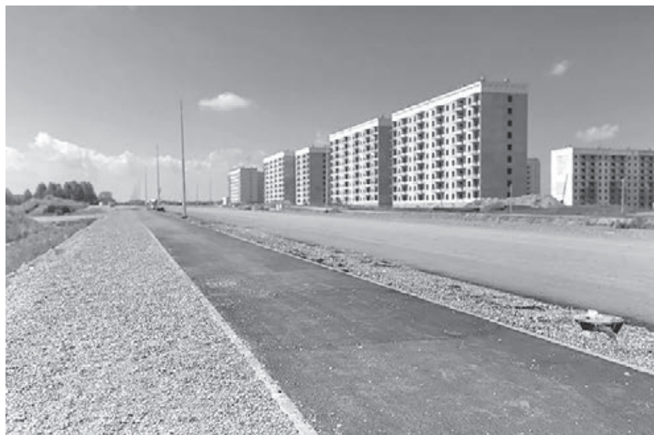
■ Строительство улично-дорожной сети в Новоильинском районе. Фото пресс-службы администрации Новокузнецка.
