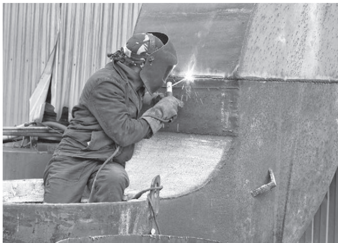
■ Работы по подготовке Кузбасса к отопительному сезону завершены на 85 процентов. Фото Федора Баранова.
