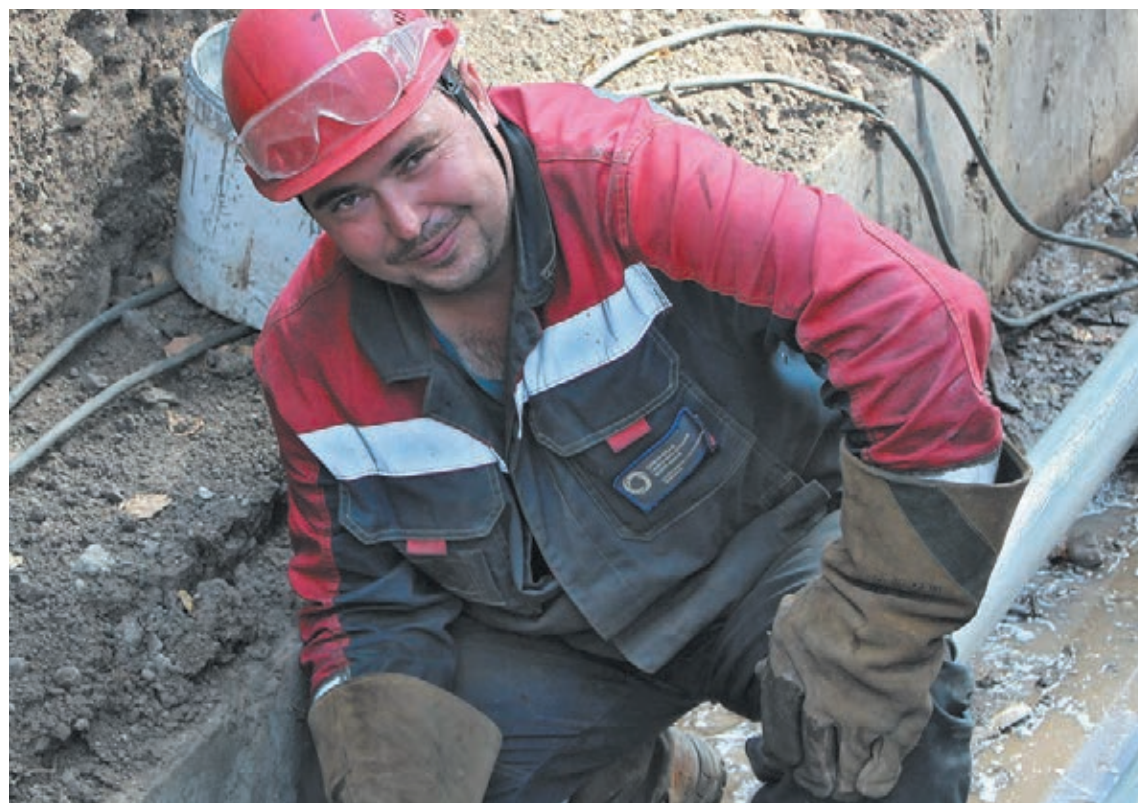
■ Григорий Рак-Рачёк готовит новые трубопроводы к теплоизоляционным работам.
