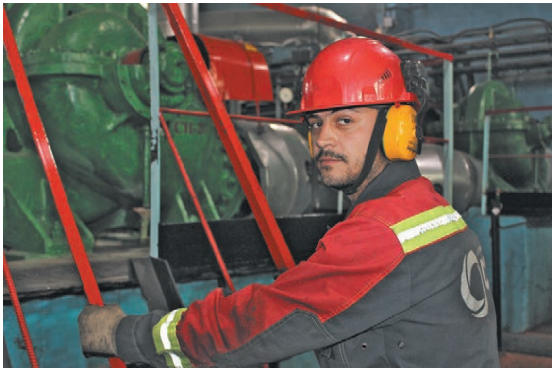
■ Дмитрий Кудинов на подкачивающей насосной станции № 16 в Новокузнецке.
