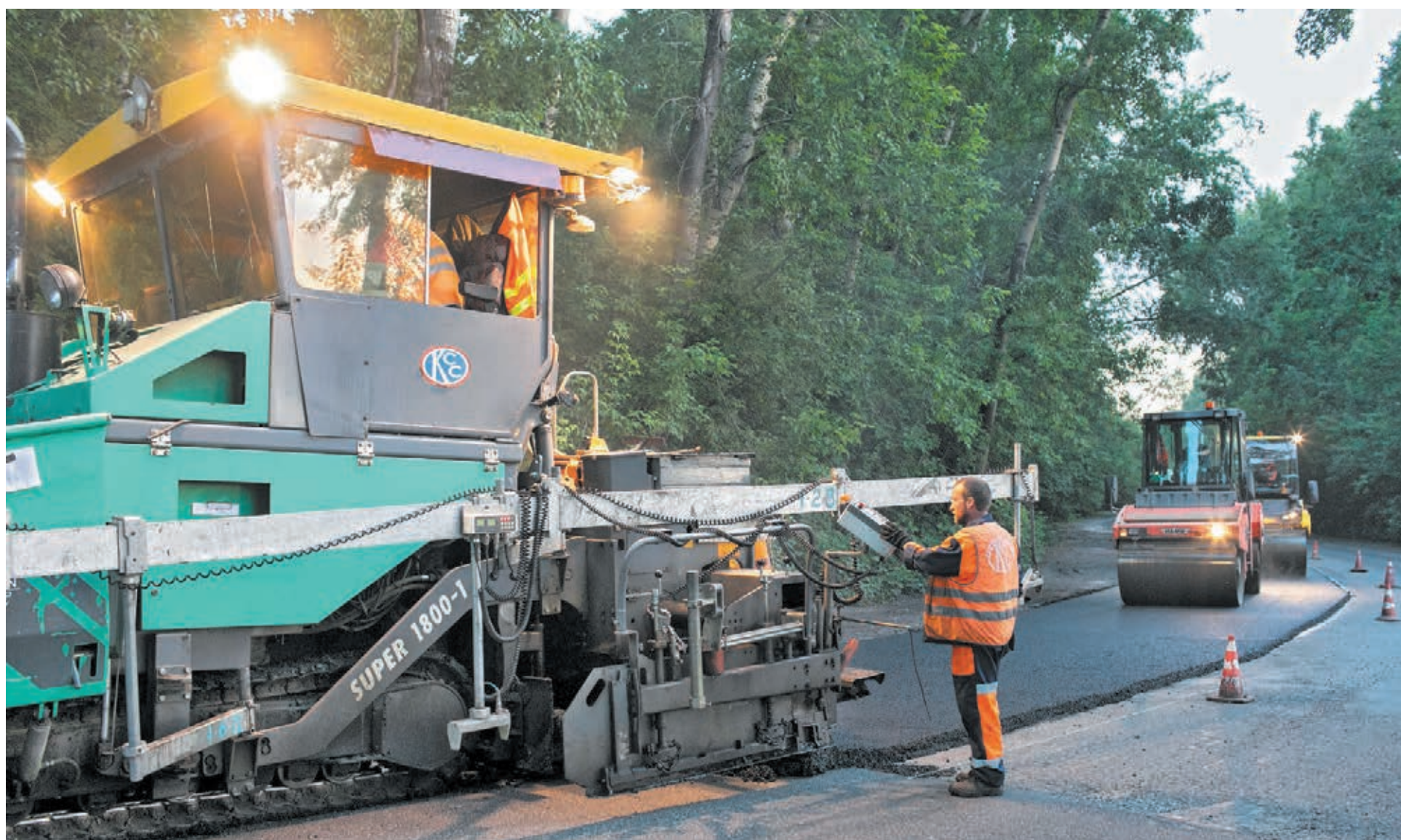
■ В этом году в Кузбассе построено и отремонтировано около 350 километров дорог. Фото Сергея Гавриленко.
