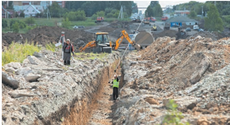
■ Уже осенью здесь будет дорога с покрытием из щебёночно-мастичного асфальтобетона. Фото Сергея Гавриленко.
