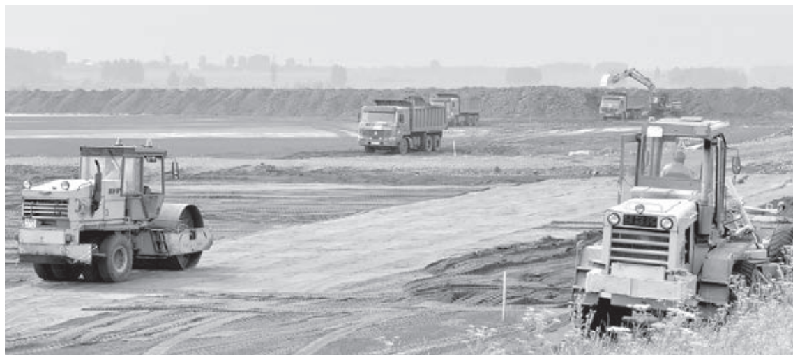
■ На Беловской ГРЭС СГК успешно провели эксперимент по рекультивации золоотвала золошлаковыми материалами.
