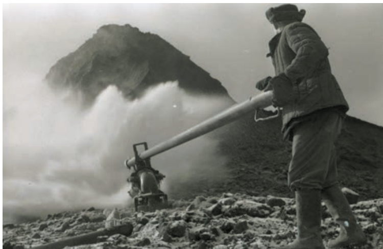
■ Гидромеханизация на Кедровском разрезе, 1950-60 гг.
