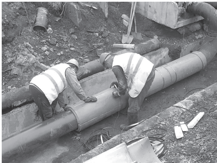
■ Специалисты ООО «ЮЭК» в работе с инженерными сетями.
