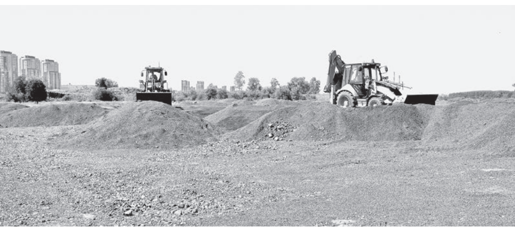
■ На месте будущего спортивного центра уже вовсю ведутся работы. Губернатор рассказывает о проекте. Фото Федора Баранова.
