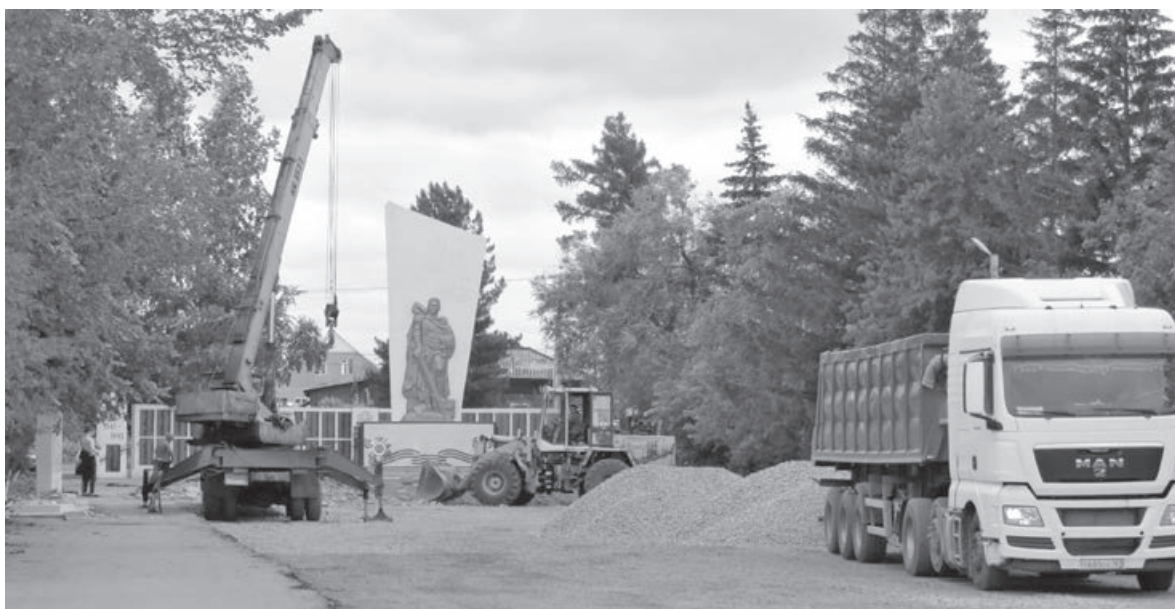
■ Строители уже приступили к работе по реконструкции. Фото автора.
