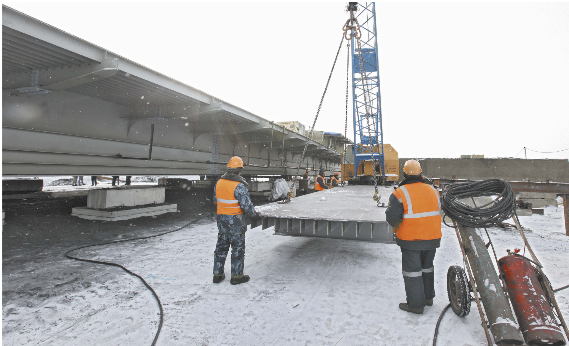
■ Процесс надвигки пролетного строения моста через реку Кия: дорожники в график укладываются. Фото Федора Баранова.
