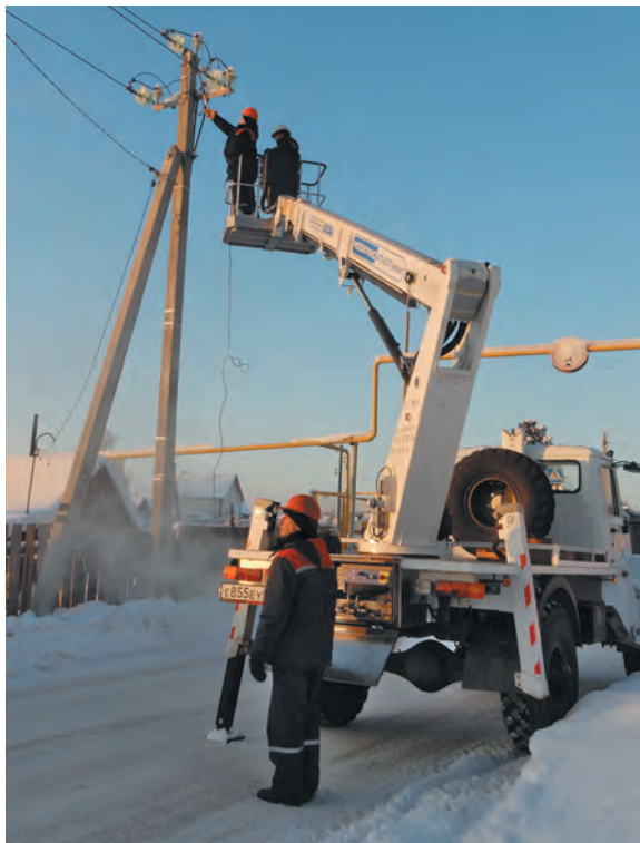
■ Замена оборудования на воздушной линии электропередачи.
