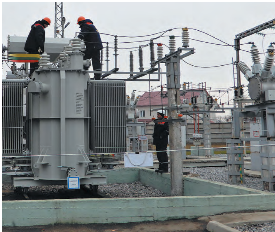
■ В 2018 году кемеровские энергетики завершили реконструкцию подстанций «Новая» и «Строммаш». В результате город получил фактически новые питающие центры.
