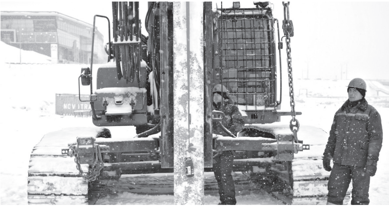
■ Первая свая в основании будущего здания VIII кассационного суда.
