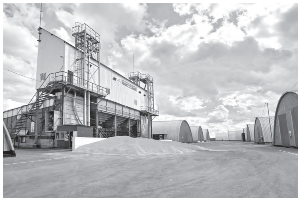
Новый сушильно-очистительный комплекс.
