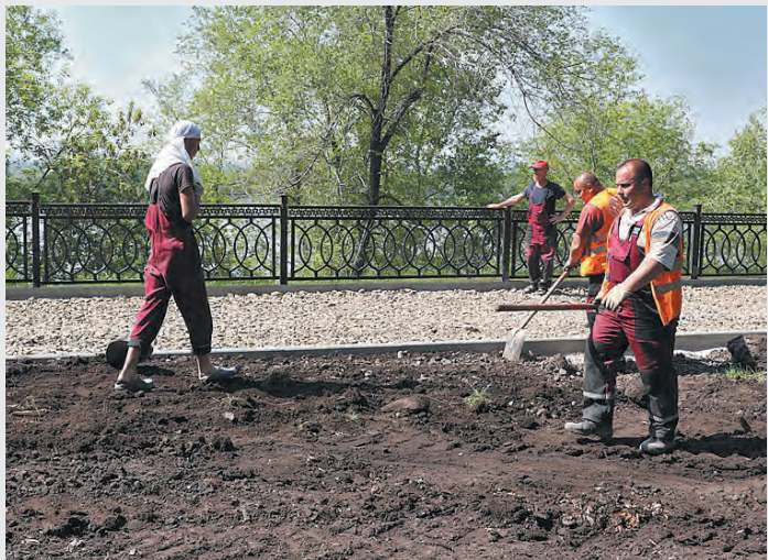
Работы на набережной в Кировском. Фото пресс-службы администрации Кемерова.
