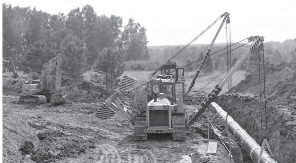
Ремонтные работы на переходе через автодорогу.
