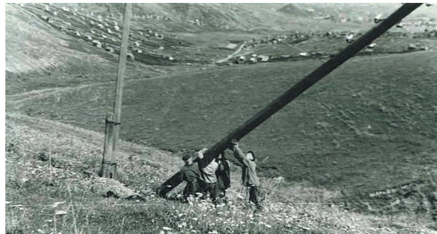
■ Ремонт линии электропередачи.
