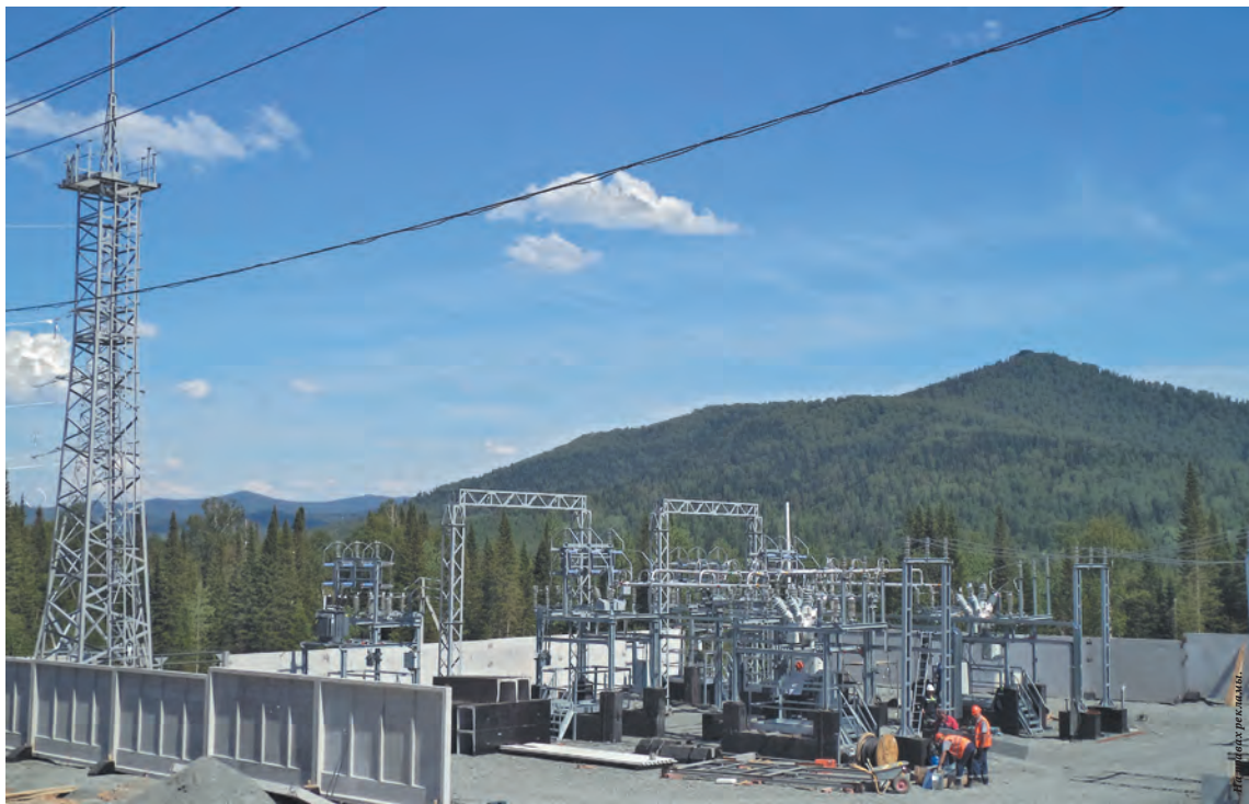
■ Строительство подстанции 35/6 кВ «Ключевая».
