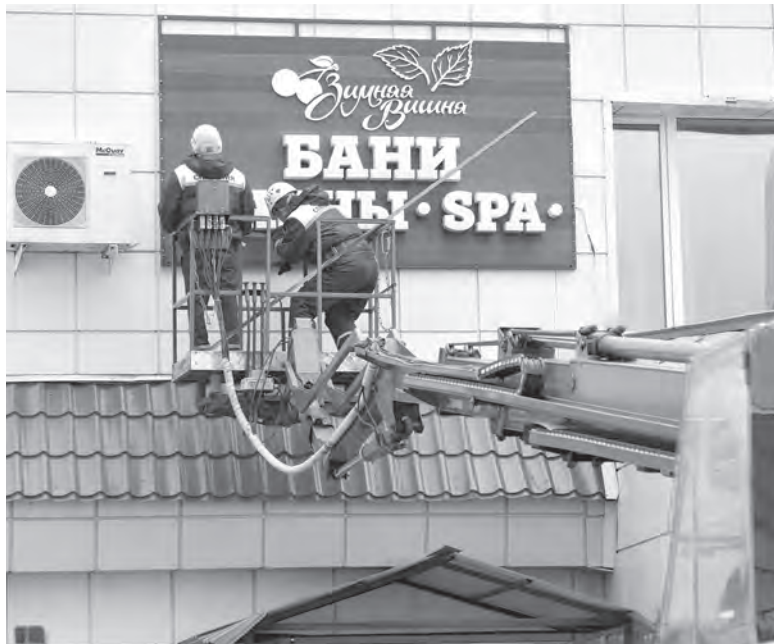
■ Демонтировать объекты ТРЦ начали со здания бани и автомойки. Последней снесут трансформаторную подстанцию. Фото Сергея Гавриленко.
