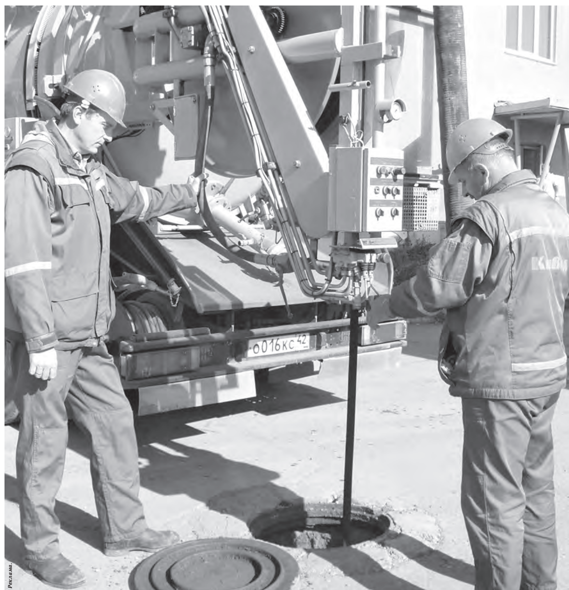
■ Каналопромывочная машина под давлением очищает подземные коммуникации от ила и других скоплений. Фото Сергея Гавриленко.
