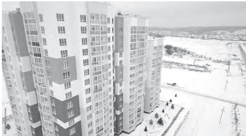
■ Строительство дома для химиков началось 27 декабря 2017 года. В нем предусмотрены одно-, двух- и трехкомнатные квартиры площадью от 34 до 71,6 кв. м. Символично, что новый дом будет расположен в конце проспекта Химиков.
