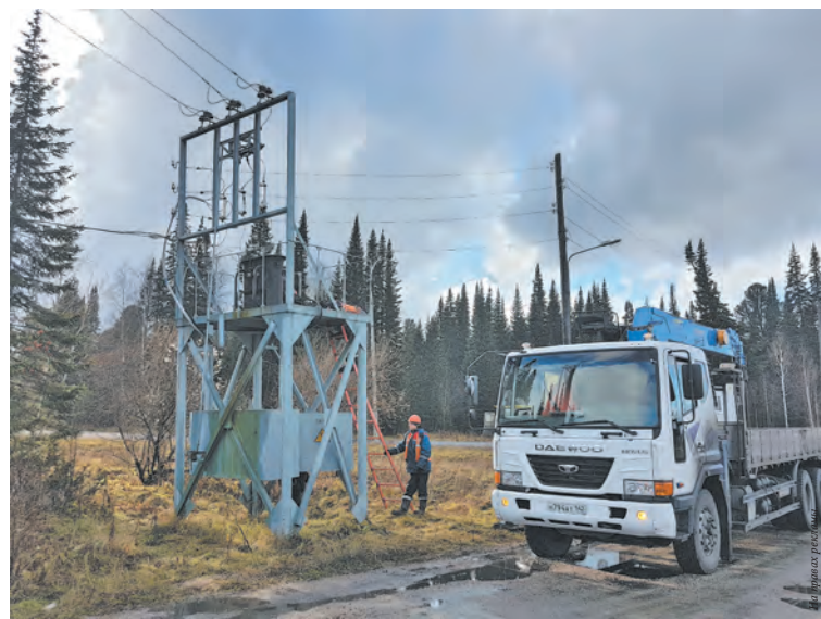
■ Замена трансформатора на МТП-114.
