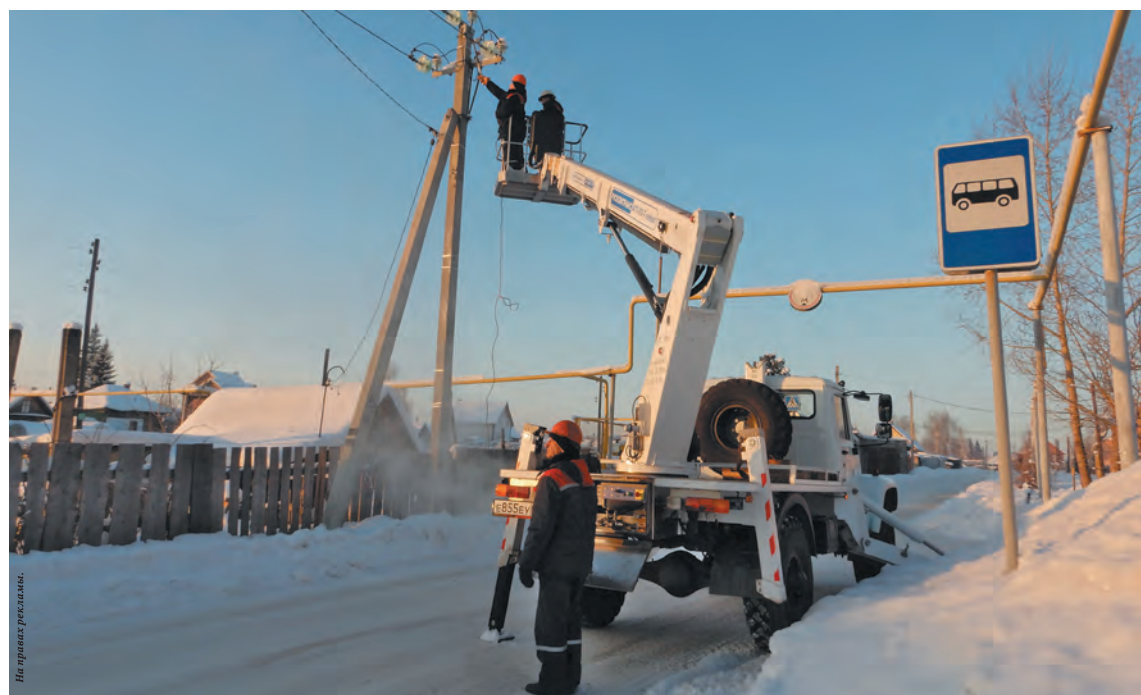
■ Верховая ревизия воздушных линий электропередачи. Фото Федора Баранова.
