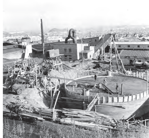
■ Строительство новой гидрошахты в Прокопьевске, 1957 год. Фото из фондов Госархива Кемеровской области.
