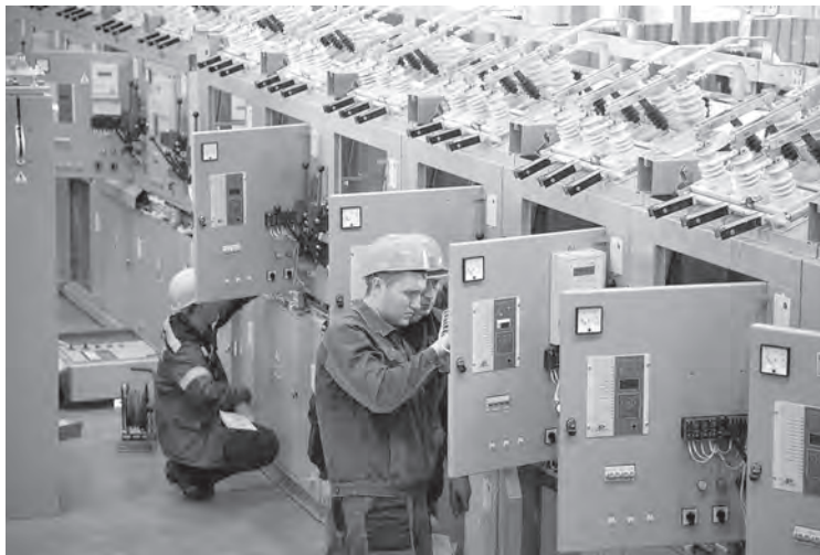
Цех по производству электрооборудования филиала «Энергосеть г. Кемерово».
