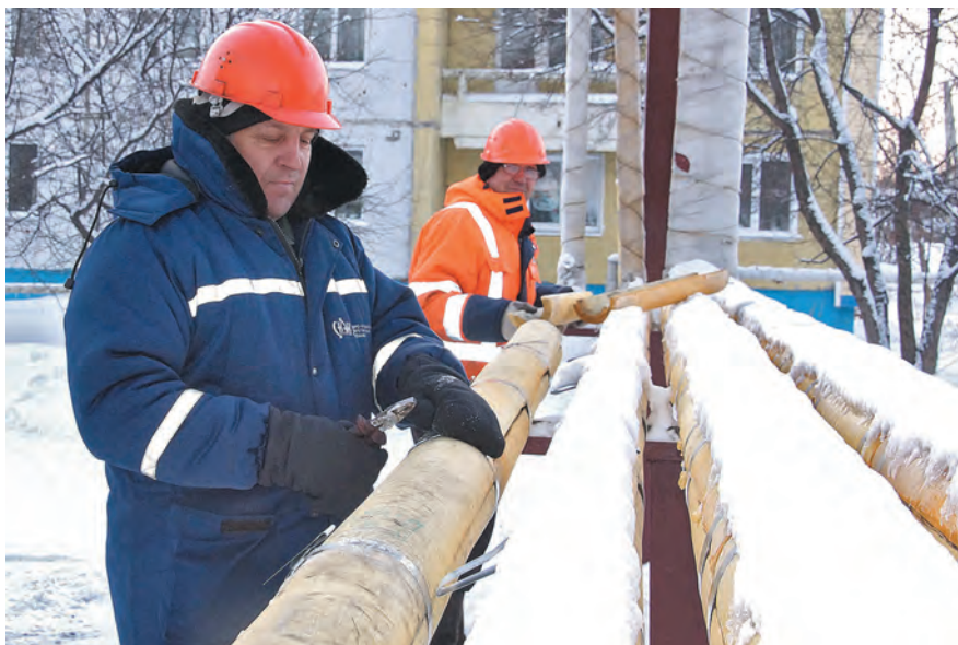
■ Монтаж теплоизоляции в поселке Плотниково.
