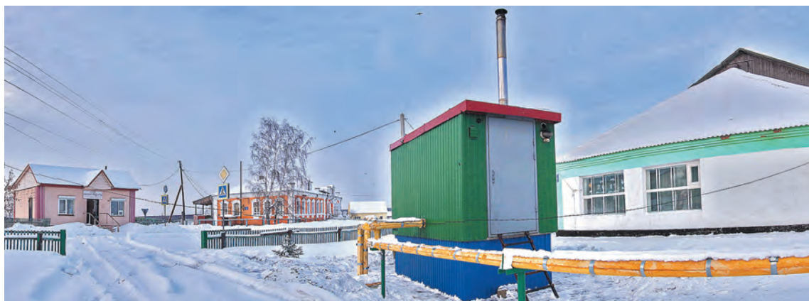
■ В Морозове смонтировали и запустили «Терморобот».
