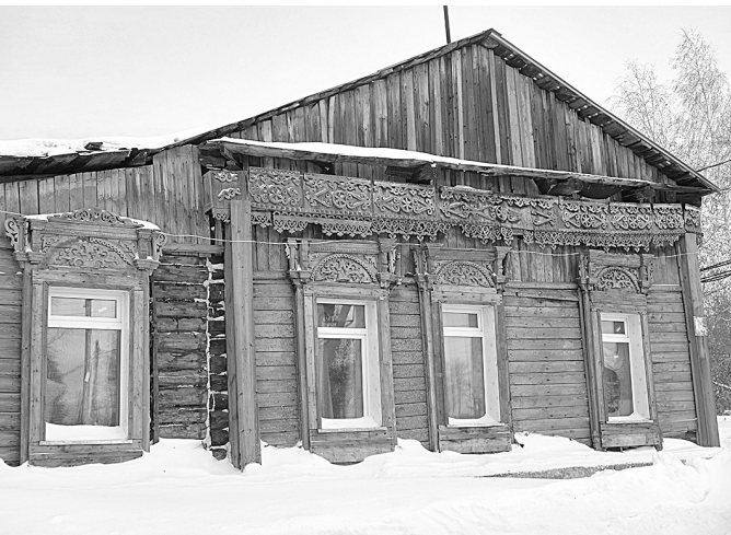
■ Дом с деревянной резьбой на проспекте Пролетарском. Фото автора.
