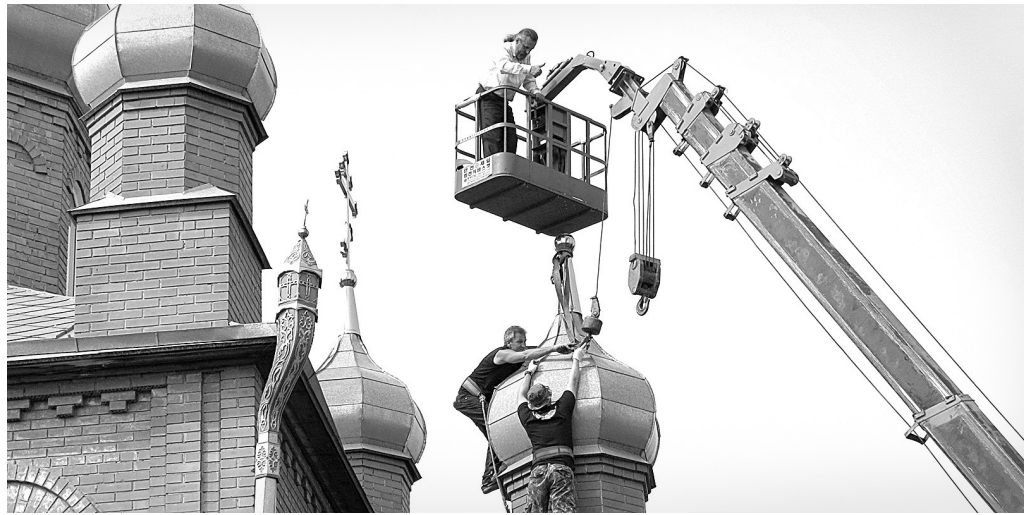
■ Отец Василий лично участвовал в высотных монтажных работах. Фото автора.
