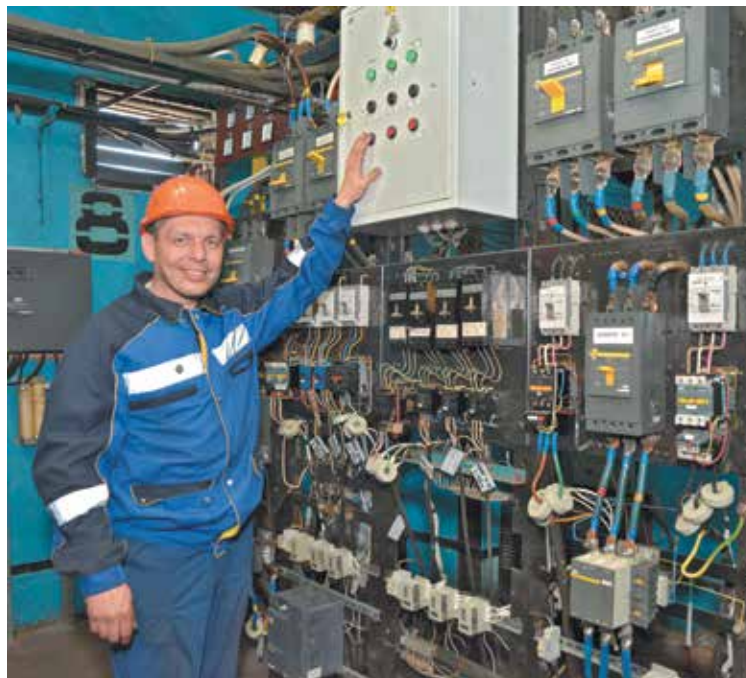
■ Настройка щита управления подпиточными насосами. Электрослесарь по ремонту и обслуживанию 4-го разряда Владлен Александрович Янькин.
