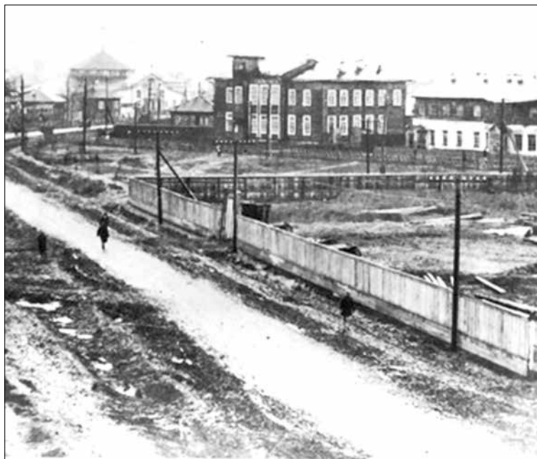
■ Площадка под строительство ДК «Москва».
