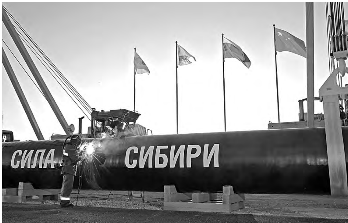
■ Торжественная сварка первого стыка газопровода «Сила Сибири».
