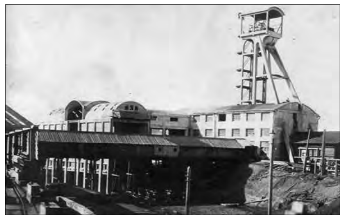
1928 год. Реконструкция шахты 5/7. Первый железобетонный копер в СССР. Фото из архива городского краеведческого музея Анжеро-Судженска.
