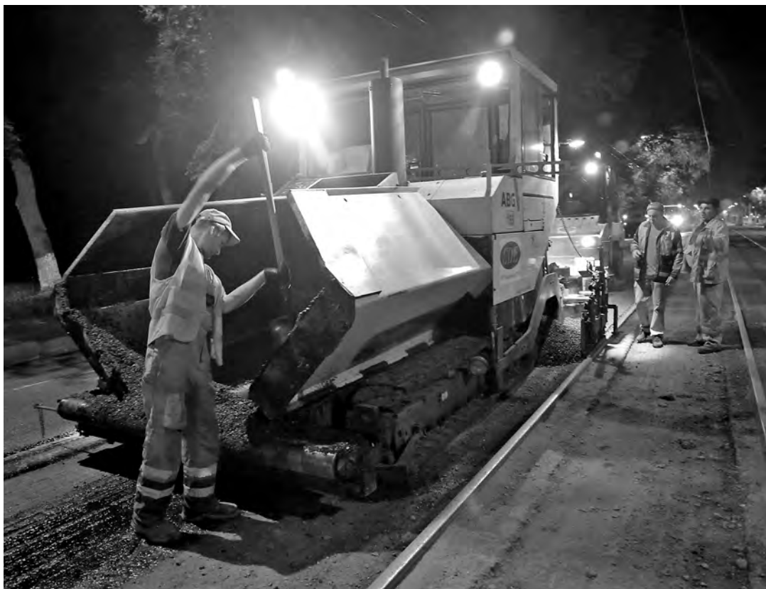
■ Перекрывать движение на проспекте власти не собираются – основные работы ведутся ночью. Фото Ярослава Беляева.
