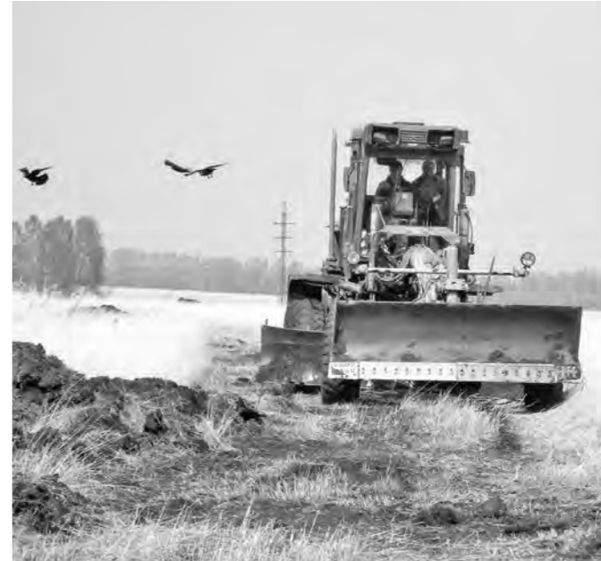
Грейдер прокладывает несанкционированную дорогу прямо по полям фермеров.
