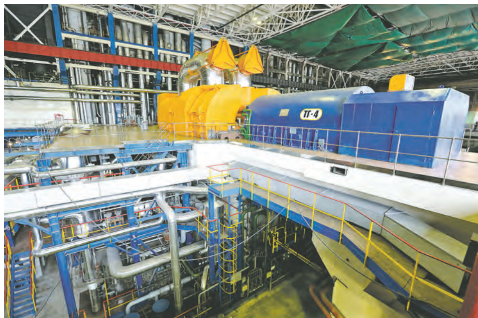
■ Энергоблок № 4 Беловской ГРЭС после своего второго рождения.
