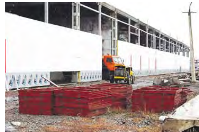
Здание блока биологической очистки.
