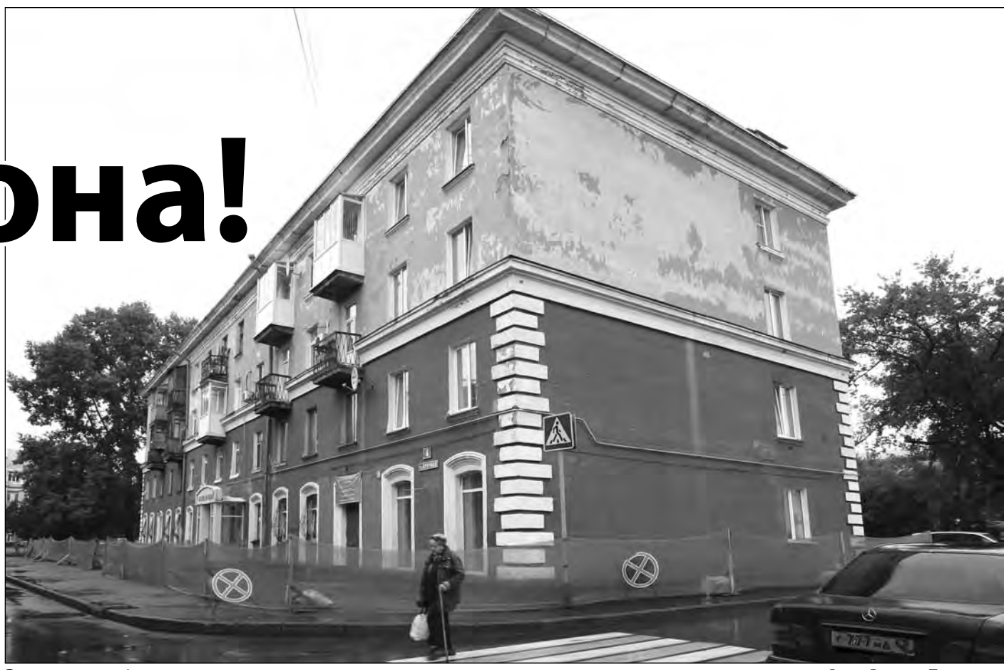
Этому дому на Арочной повезло попасть в программу капремонта. Фото Федора Баранова.
