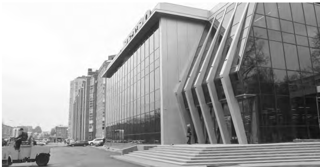
Последние приготовления к открытию.
