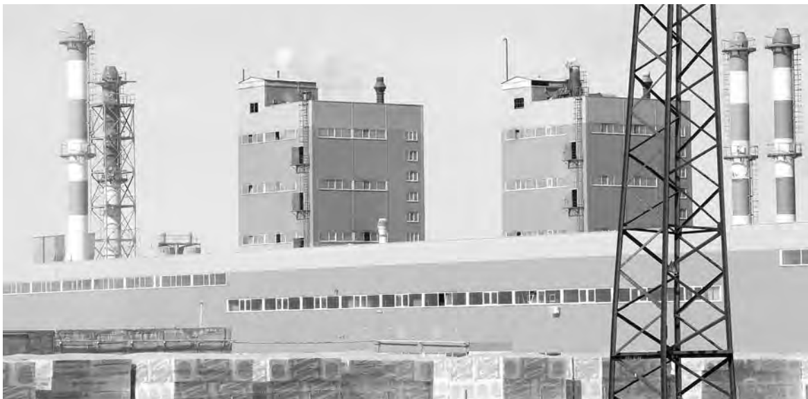
Сегодня в Юрге реализуется программа диверсификации экономики, часть которой – ввод в эксплуатацию завода по производству минеральных тепло- и звукоизоляционных материалов «ТехноНИКОЛЬ». Фото Евгения Тамбовцева.
