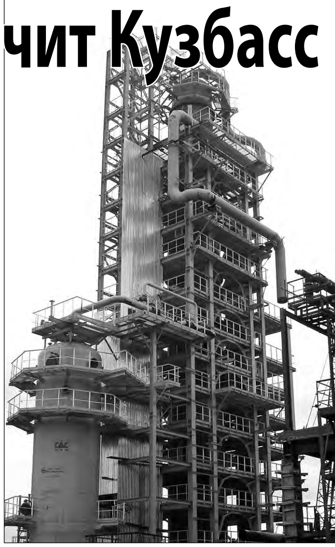
Монтаж основного технологического оборудования завершен.
