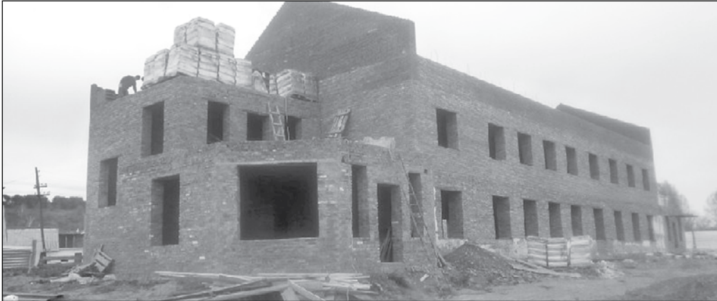
Полностью возведена коробка здания.
