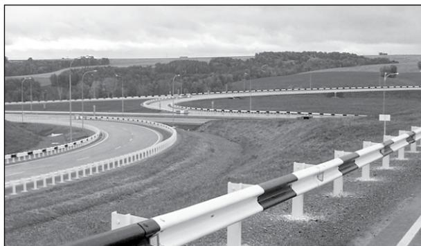
Строители «Кемеровоспецстрой» заканчивают капитальный ремонт участка автомобильной дороги федерального значения М-53 «Байкал» на территории города Березовский протяженностью 8 км. При интенсивном движении транзитного транспорта выполнялись работы по уширению земляного полотна и усилению дорожной одежды. Несмотря на очень сложные условия, приложены все усилия, чтобы объект был сдан в
