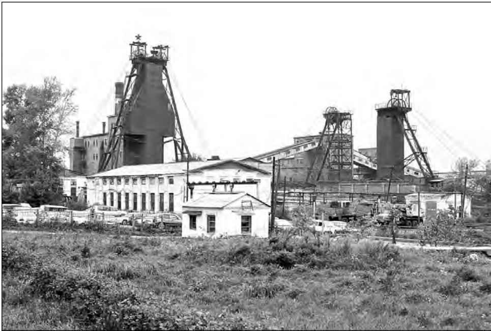
Год назад шахта «Тырганская» выглядела так. До конца года она будет ликвидирована.
