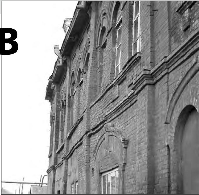
Выпуклые стены - не оптический обман.
