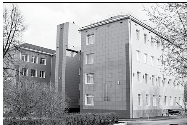
Здание поликлиники после реконструкции.
