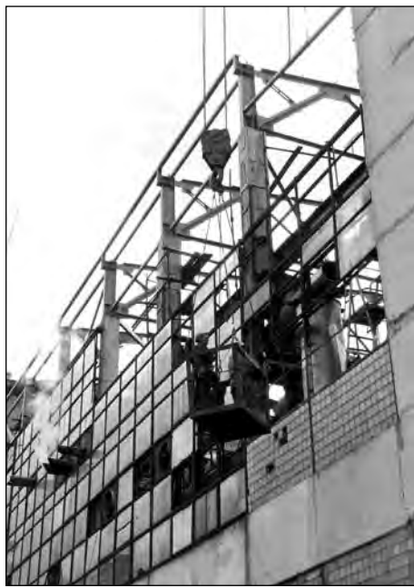
В цехе ГАС ведутся восстановительные работы.
